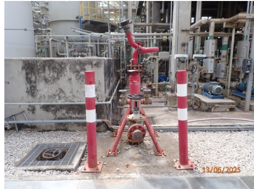
รูปที่ 54 หัวจ่ายน้ำดับเพลิง (Firewater Monitor)
