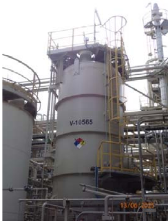
รูปที่ 11 ถังพักน้ำที่มีสารอะคริโลไนไตรล์ปนเปื้อน ประเภท Pressured Vessel (V-10565)
