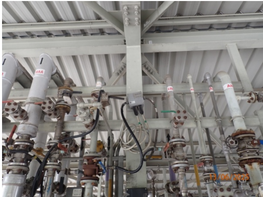
รูปที่ 59 วาล์วควบคุมบริเวณแนวท่อขนส่งวัตถุดิบ
