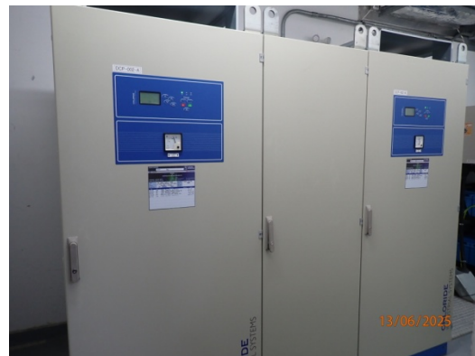
รูปที่ 8 ระบบไฟสำรองแบบยูทีเอส (UPS)
