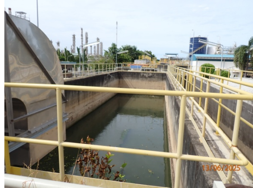
รูปที่ 16 บ่อพักฉุกเฉิน (Remote Impoundment Pond)
