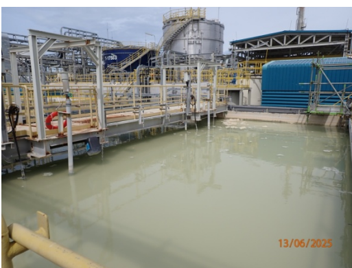
รูปที่ 19 ระบบบำบัดน้ำเสียแบบตะกอนเร่ง (Activated Sludge)
