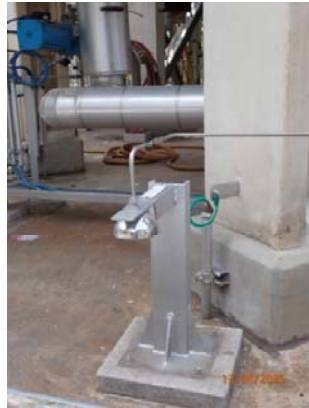
รูปที่ 47 Gas Monitoring System
