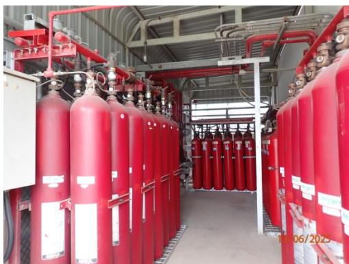
รูปที่ 57 ระบบก๊าซไนโตรเจน (Nitrogen Blanketing) บริเวณถังเก็บกาก
