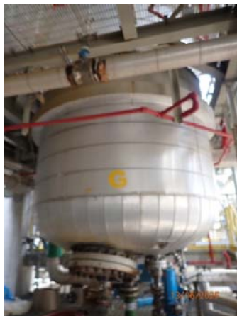
รูปที่ 51 ระบบการพ่นน้ำลงบนถังปฏิกิริยา (Reactor)
