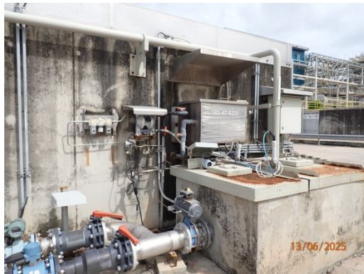
รูปที่ 23 จุดตรวจวัดคุณภาพน้ำอัตโนมัติ
