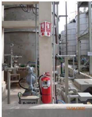
รูปที่ 55 ถังดับเพลิงแบบมือถือ (Portable Fire Extinguisher)
