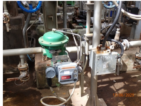
รูปที่ 2 ระบบวาล์วควบคุม (Control Valves)
