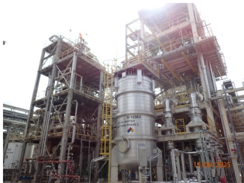
รูปที่ 3 ระบบนำอะคริไลไนไตรด์กลับมาใช้ใหม่
