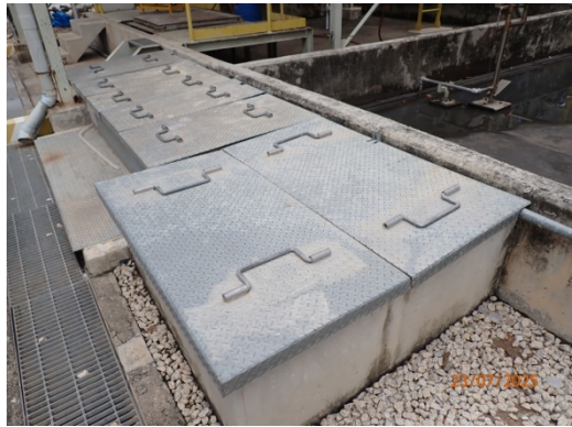
รูปที่ 18 บ่อพักน้ำเสียในพื้นที่ (Sump Pit)
