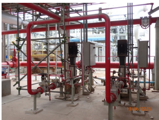
รูปที่ 63 เครื่องสูบน้ำรักษาแรงดัน (Jockey Pump)
