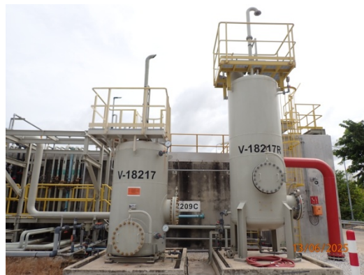
รูปที่ 9 ระบบหอดูดซับด้วยถ่านกัมมันต์ (AC Unit)
