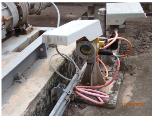
รูปที่ 67 Gas Detector
