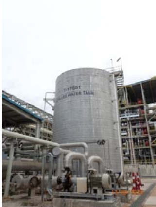
รูปที่ 53 ระบบน้ำเย็น (Chilled Water)
