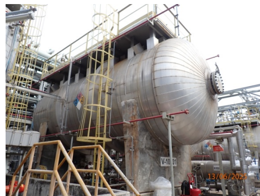
รูปที่ 62 ถังเก็บ 1,3-บิวทาไดอินที่มีฉนวนหุ้ม
