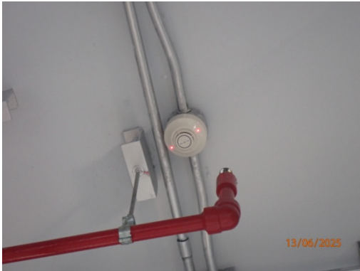
รูปที่ 69 อุปกรณ์ตรวจจับความร้อน (Heat Detector)
