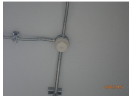
รูปที่ 68 อุปกรณ์ตรวจจับควัน (Smoke Detector)
